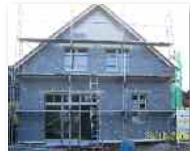
Fassadendämmung mit Wärmedämmverbundsystem
